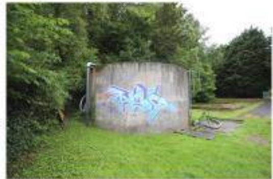
silo à boues
